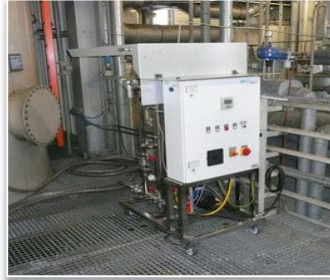
UV-Anlage UXPM OX 7000 E auf fahbarem Gestell Deutschland
