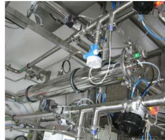
UV-Anlage in Pharmaausführung zur Restozonvernichtung EL-PH 089 für 12m 3 /h Deutschland
