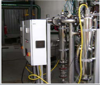
2 x UXPM OX 7000 E zur AOP- Behandlung im Prozesswasser Brasilien
