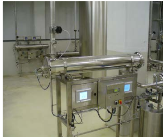
UV-Anlage in Pharmaausführung zur Restozonvernichtung EL-PH 165 für 23m 3 /h Türkei
